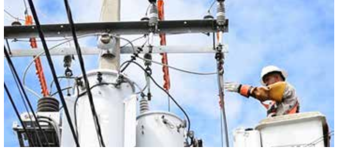
ELEKTRİFİKASYON İŞLERİ / ELECTRIFICATION WORKS
